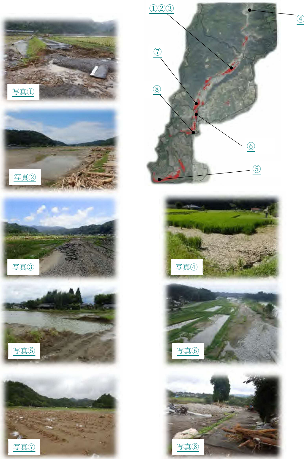
〔写真〕 農地等被害箇所と被災状況
