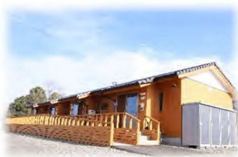
運動公園仮設団地
