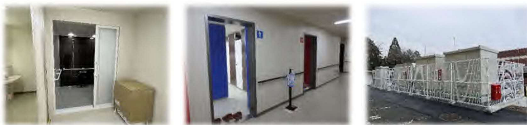
〔写真〕改修された相良村総合体育館
